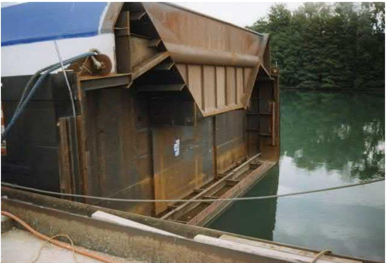
**Eine Sektion, der Förderbandtunnel ist provisorisch mit einer Stahlplatte verschlossen**
