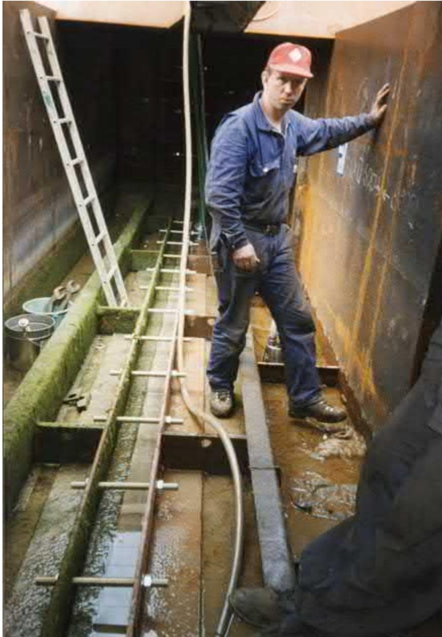
**Die beiden Sektionen sind mit Bolzen zusammengefügt und gerichtet worden, alles bereit zum endgültigen Zusammenschweißen.**
