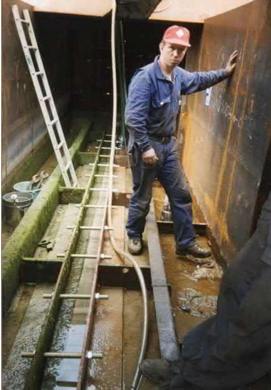
**Les sections sont ajustées et tenues en position par des boulons, tout est maintenant prêt pour la soudure définitive**
