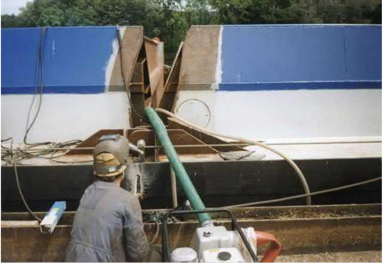
**Travaux de soudure par-dessus bord. A l'intérieur, l'eau doit être pompée continuellement**
