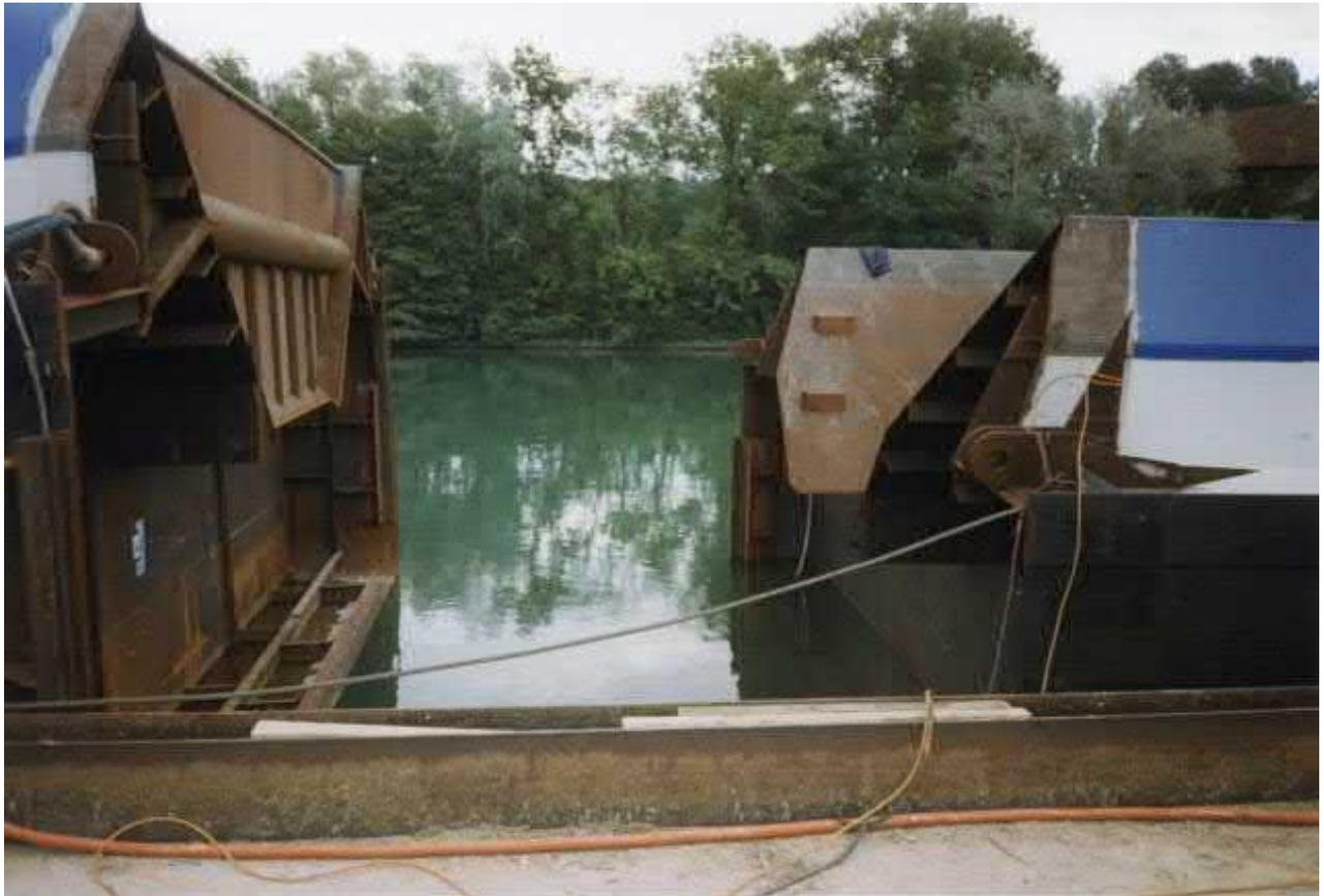
**position de jonction des deux sections, mise en place imminente**
