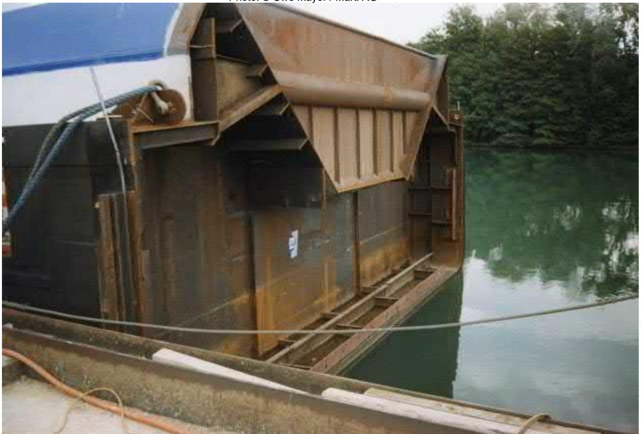
**Une section, le tunnel du tapis roulant est fermé provisoirement avec une tôle d'acier**
