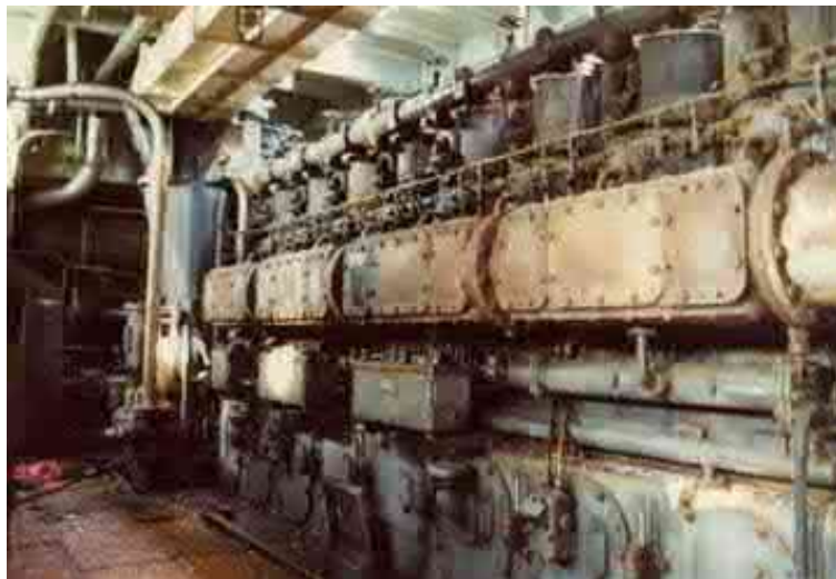
Backbordmaschine der UNTERWALDEN kurz vor dem Ausbau nach langer Stilllegung
