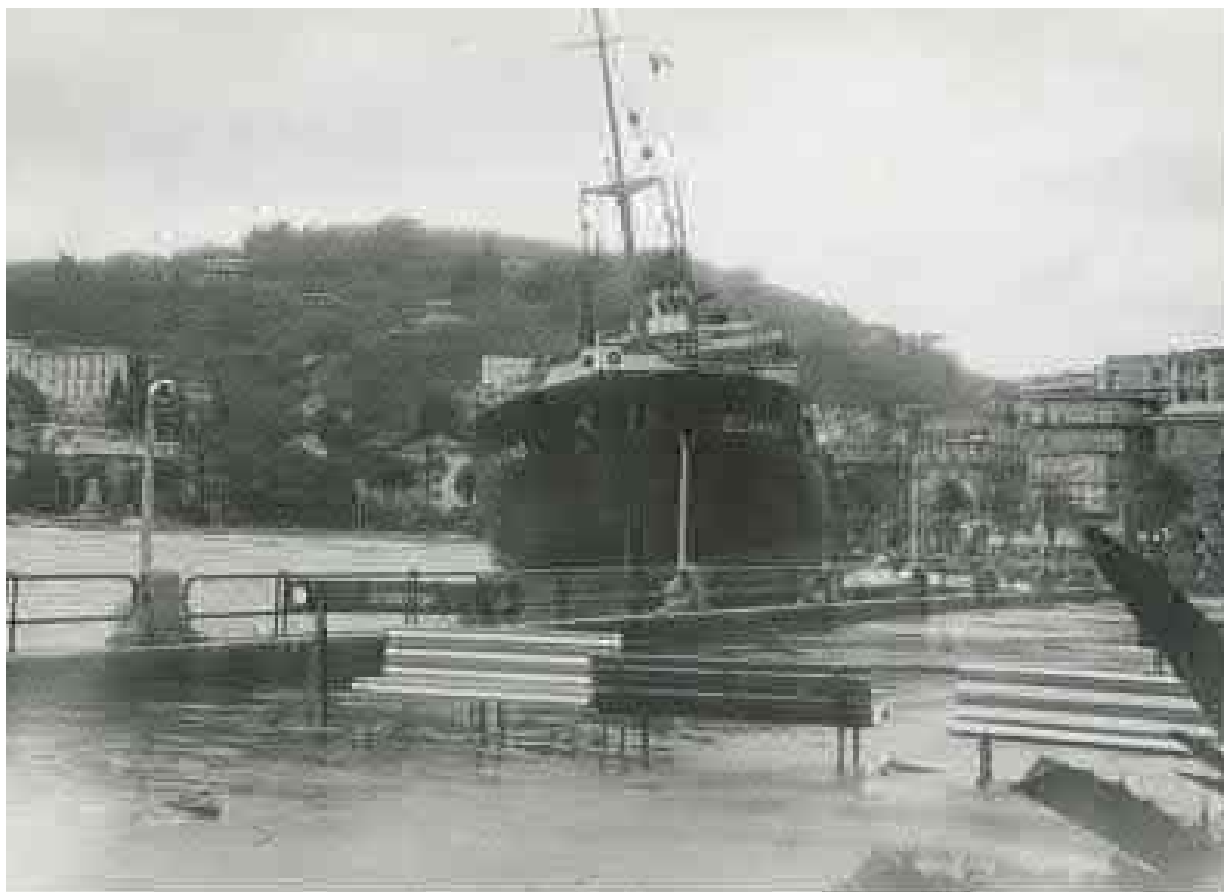
In questa fotografia della LOCARNO si nota la mancanza della catena dell'ancora di dritta
